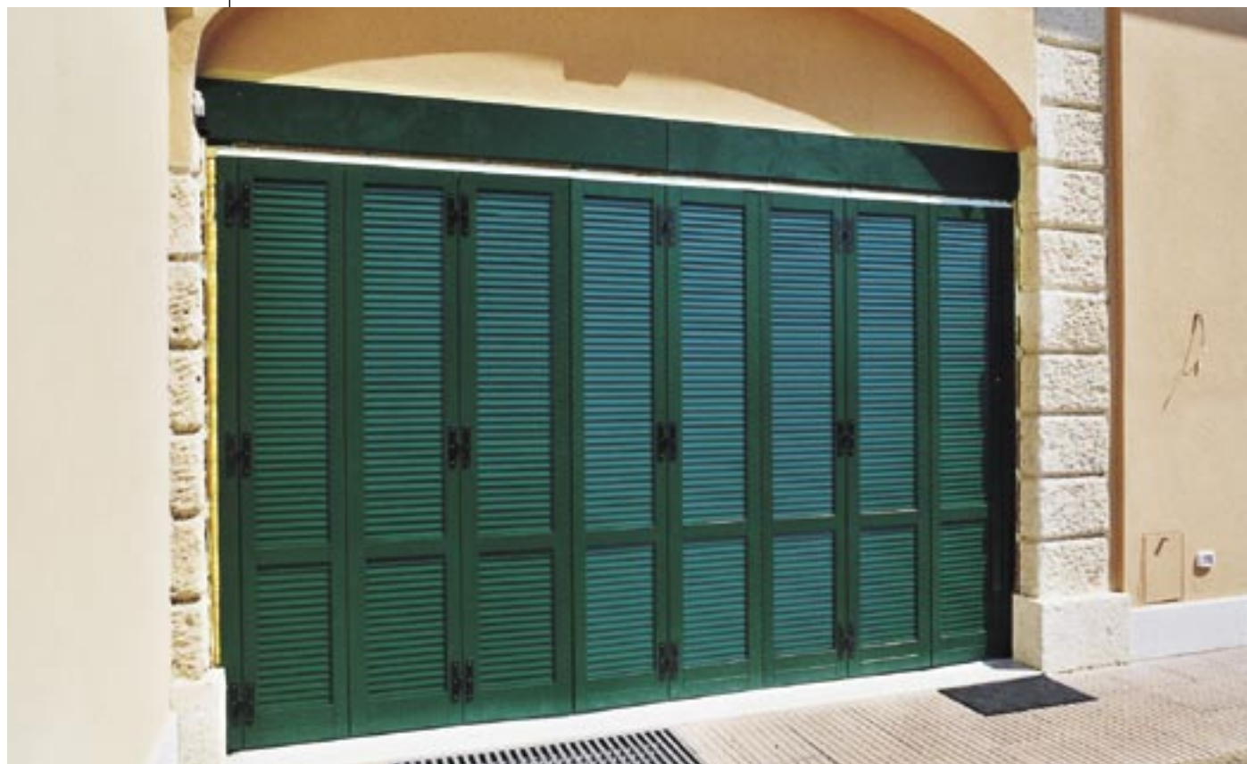
Il vano con l'importante chiusura, avente una luce architettonica di 5,60 m.
